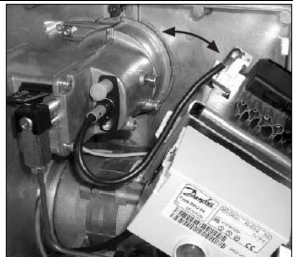
Рисунок 30 – Снятие блока управления
